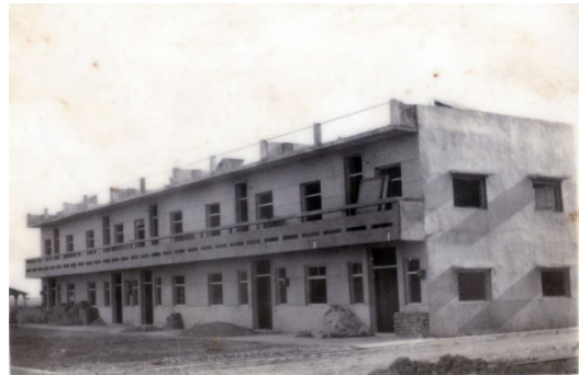
圖 39 頂山 28 戶連棟雙層住宅興建時照片。 （頂山代天府提供）
