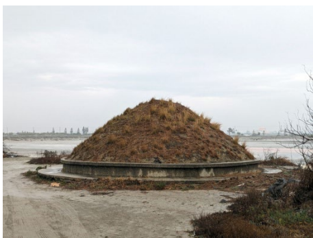
圖 29 頂山北側土崙現況（本研究攝影）
