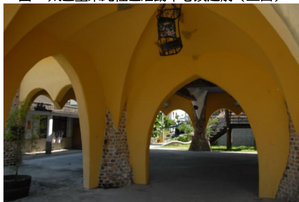
圖 3 大量打除牆壁後如通透的亭棚
